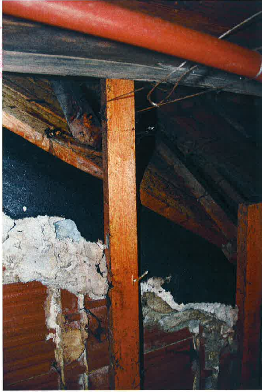
Fot. 8. Widok więźby dachowej – kosze uszczelnione papą jutową – podczas wymiany pokrycia wykonać obróbki z blachy tytan-cynk
