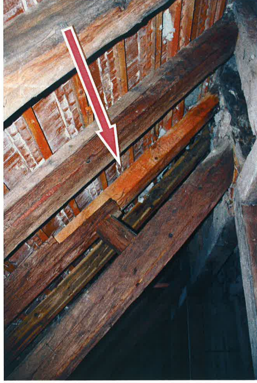
Fot. 14. Widok więźby dachowej – Wymieniona krokiew o zmniejszonym przekroju – krokiew w całości do wymiany
