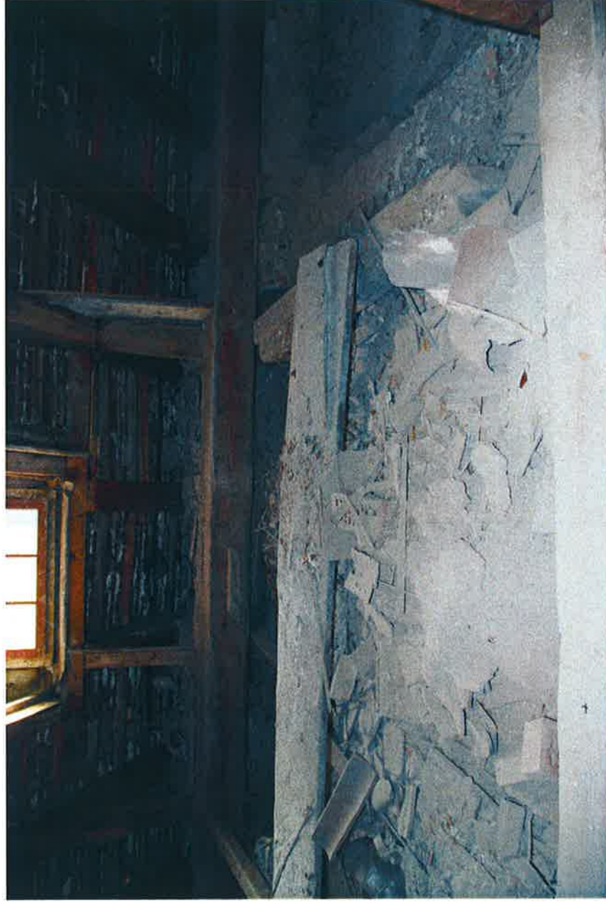
Fot. 20. Gruzowisko na stropie – do usunięcia
