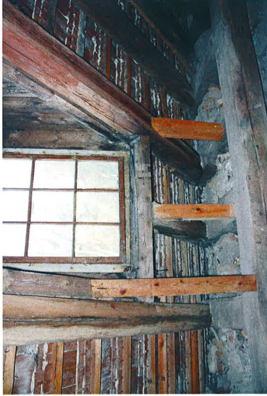
Fot. 15. Widok więźby dachowej – Wzmocnienie elementów konstrukcji lukarny – wykonać odtworzenie więźby do pierwotnego stanu
