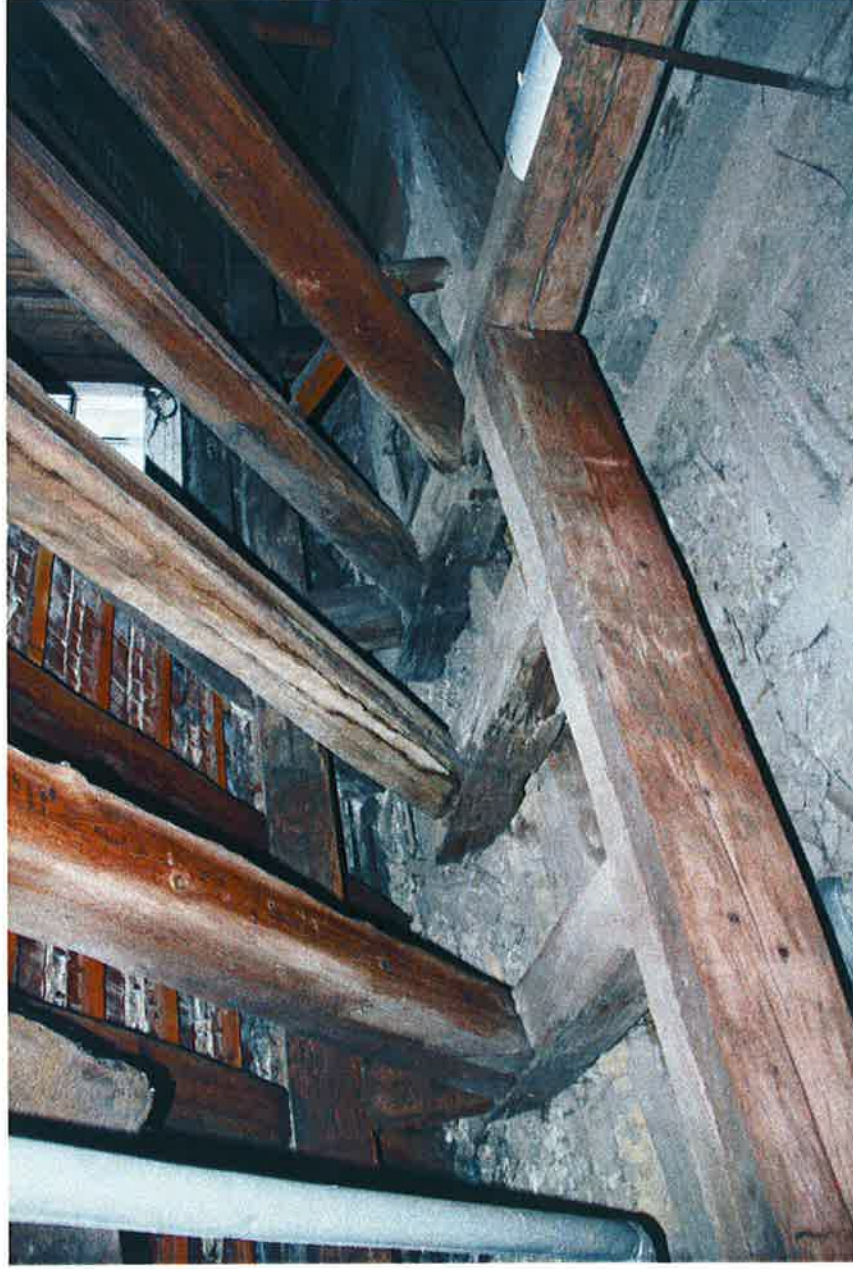
Fot. 6. Widok więźby dachowej – połączenie krokwi w węźle okapowym
