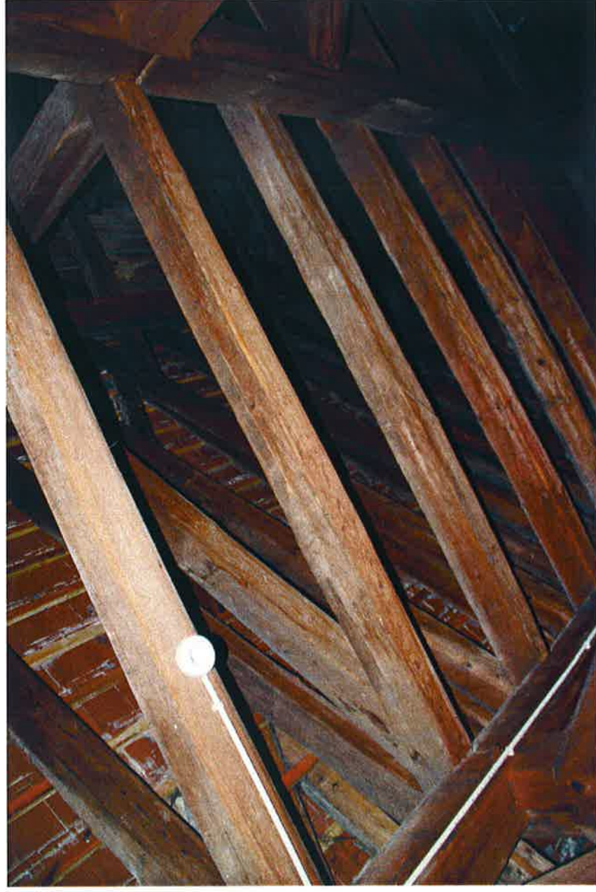
Fot. 9. Widok więźby dachowej – górny pas więźby dachowej – widoczne czujki dymu – do zachowania
