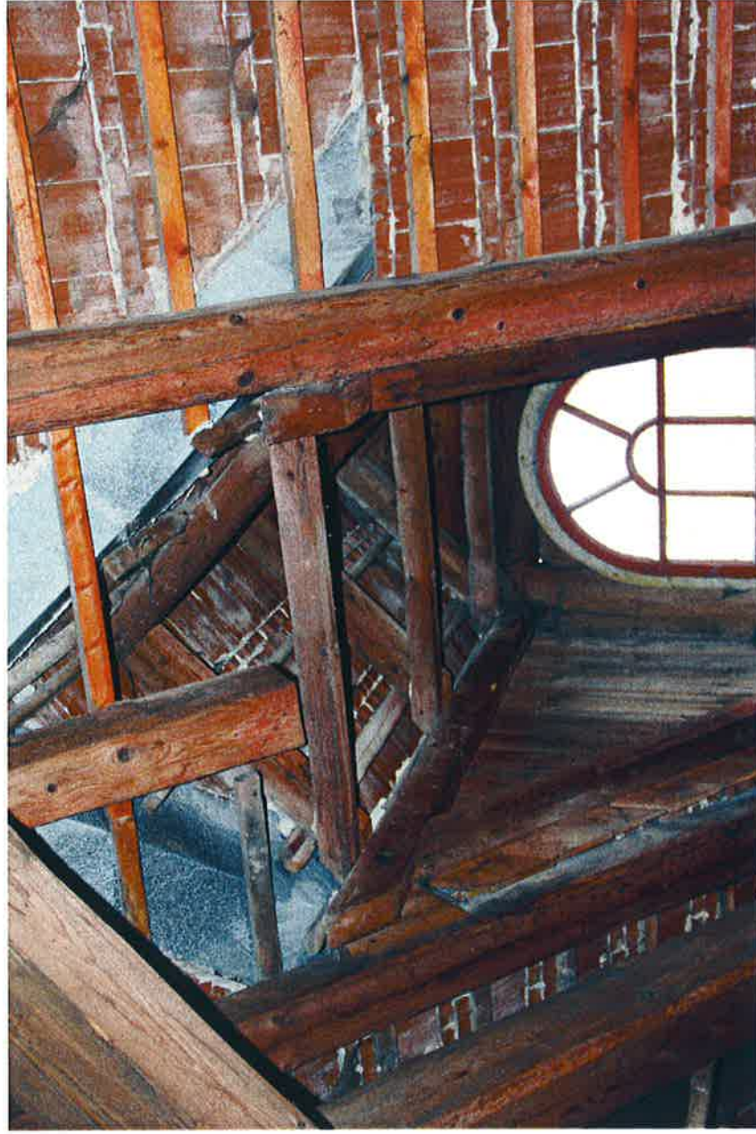
Fot. 18. Widok konstrukcji lukarn – błędne wykonanie połączeń krokwi – należy odnowić do pierwotnego stanu
