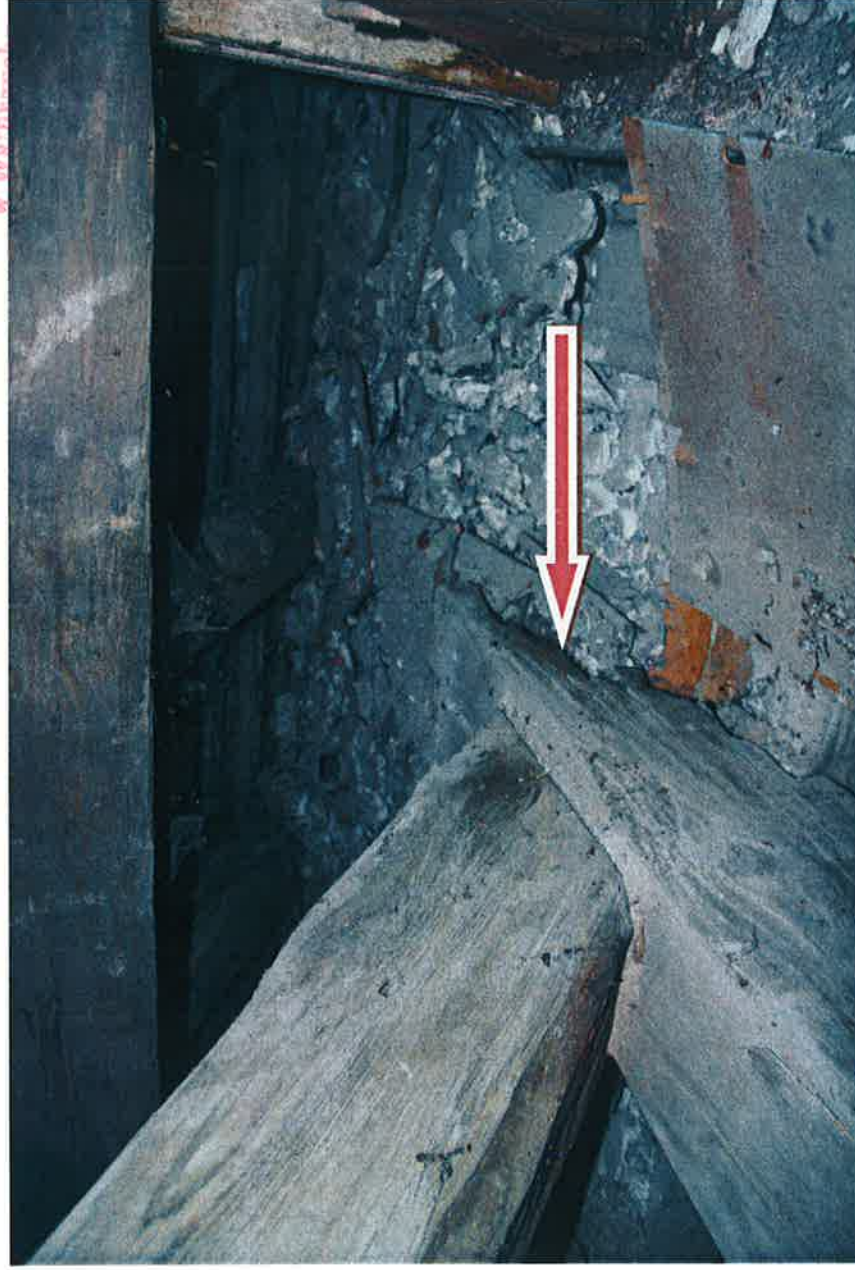
Fot. 12. Widok więźby dachowej – skorodowana podwalina
