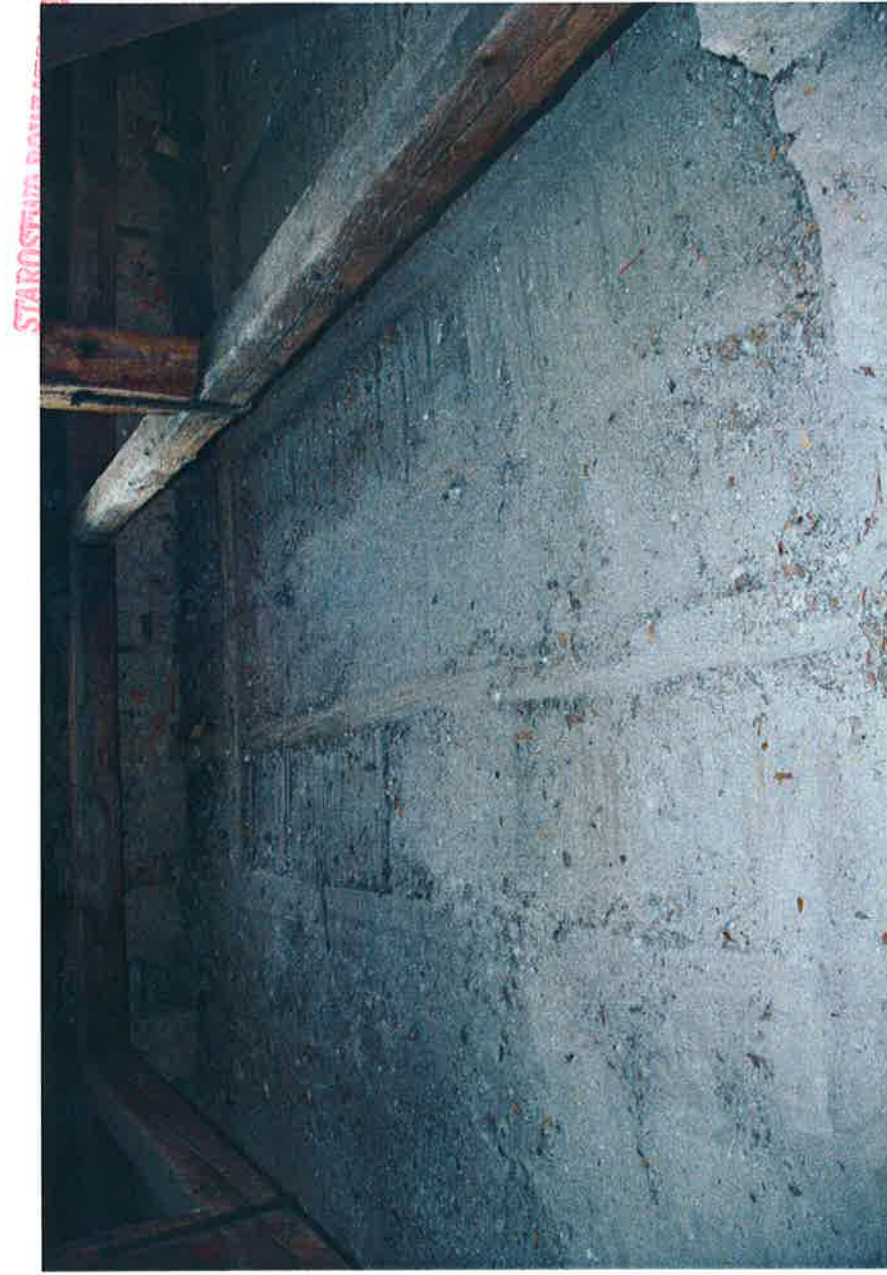
Fot. 17. Widok podłogi poddasza – widoczna utrata stateczności belek stropowych – poddać przeglądowi. Usunąć ślepy pulap z zasypką, wymienić belki stropowe.
