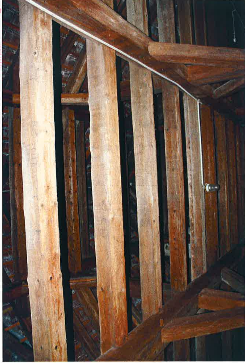
Fot. 25. Widok więźby dachowej – belki poziomu górnego – jętki
