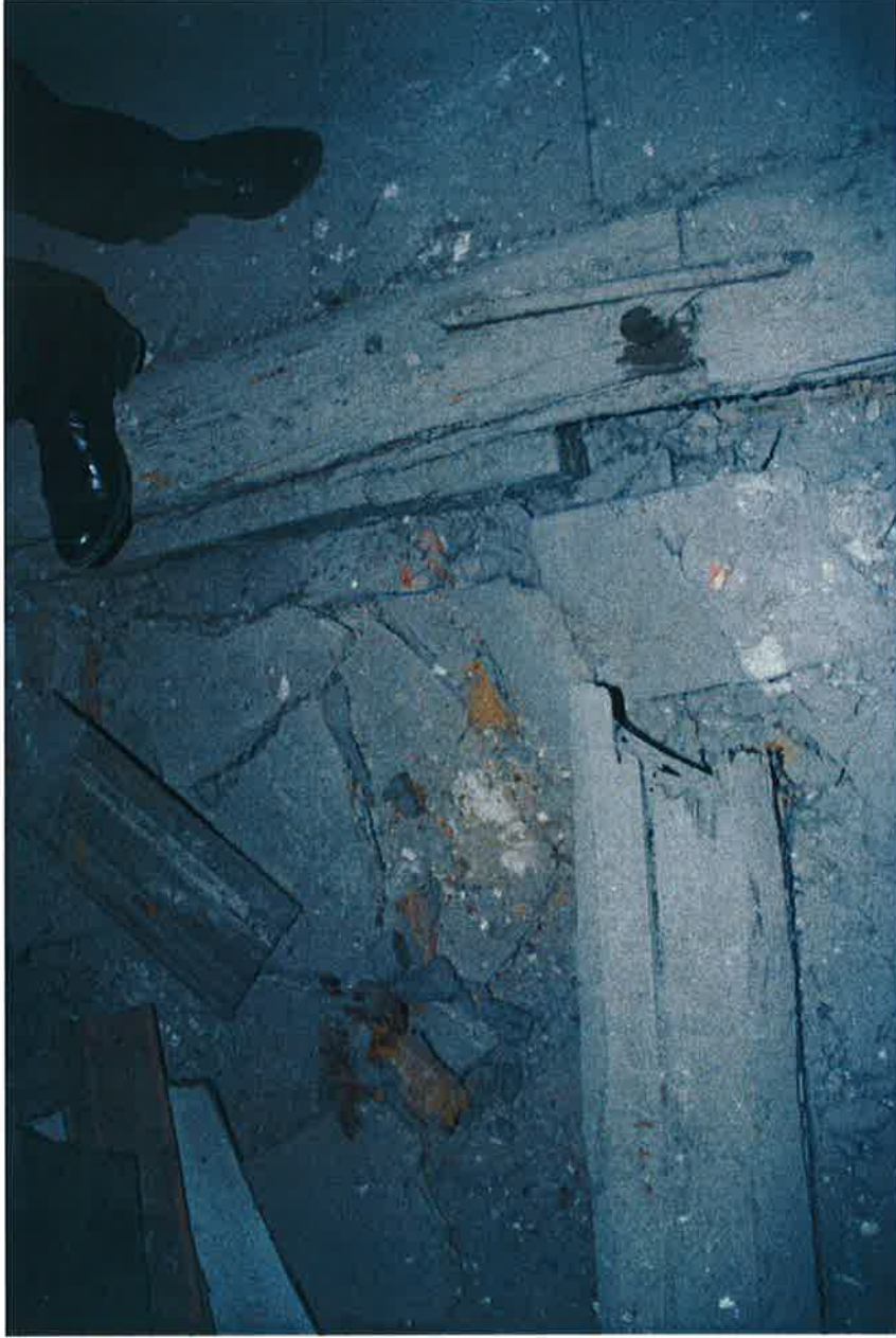
Fot. 11. Widok belki stropowej – do wymiany
