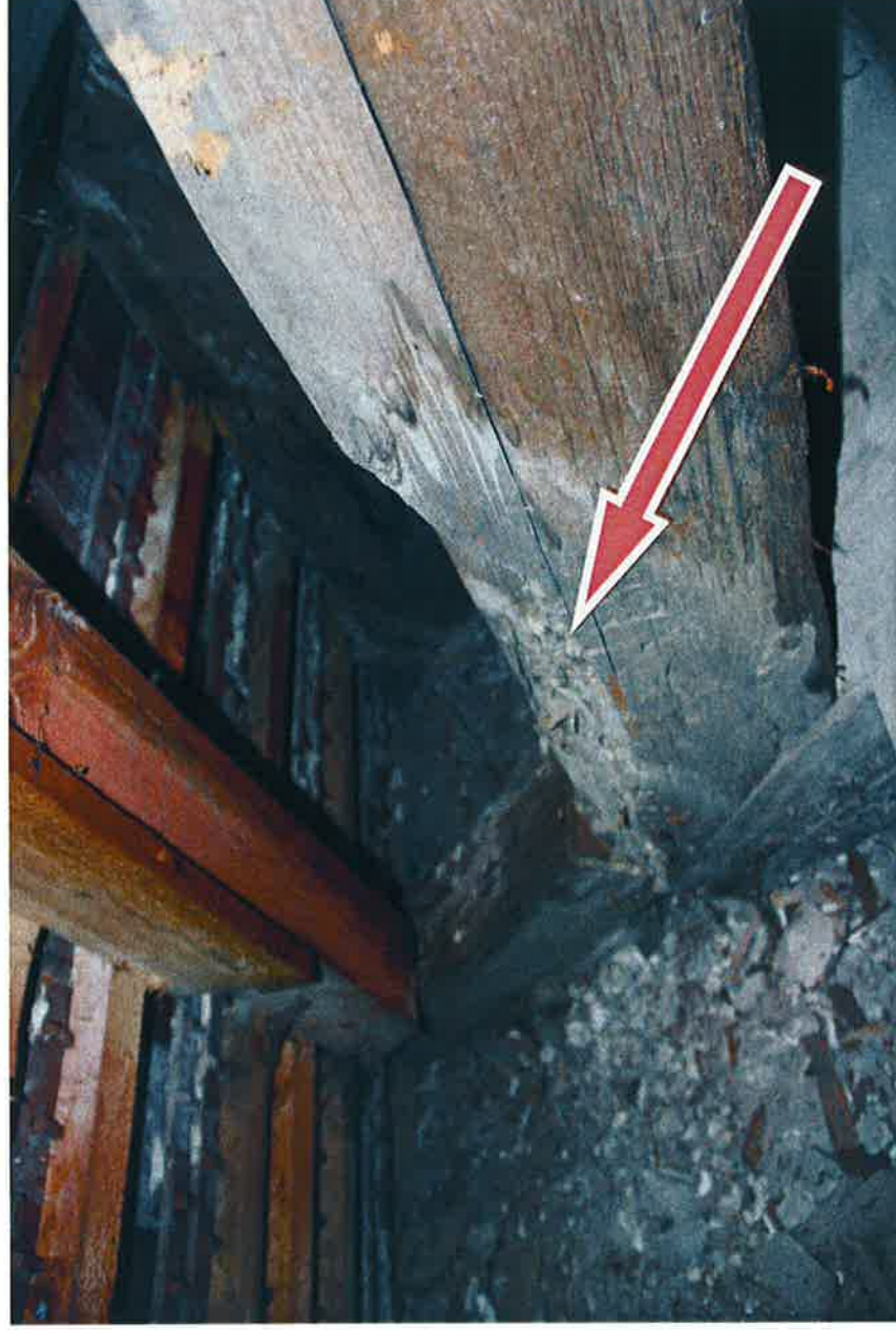
Fot. 14. Widok więźby dachowej – Ubytki przekroju krokwi – do wymiany
