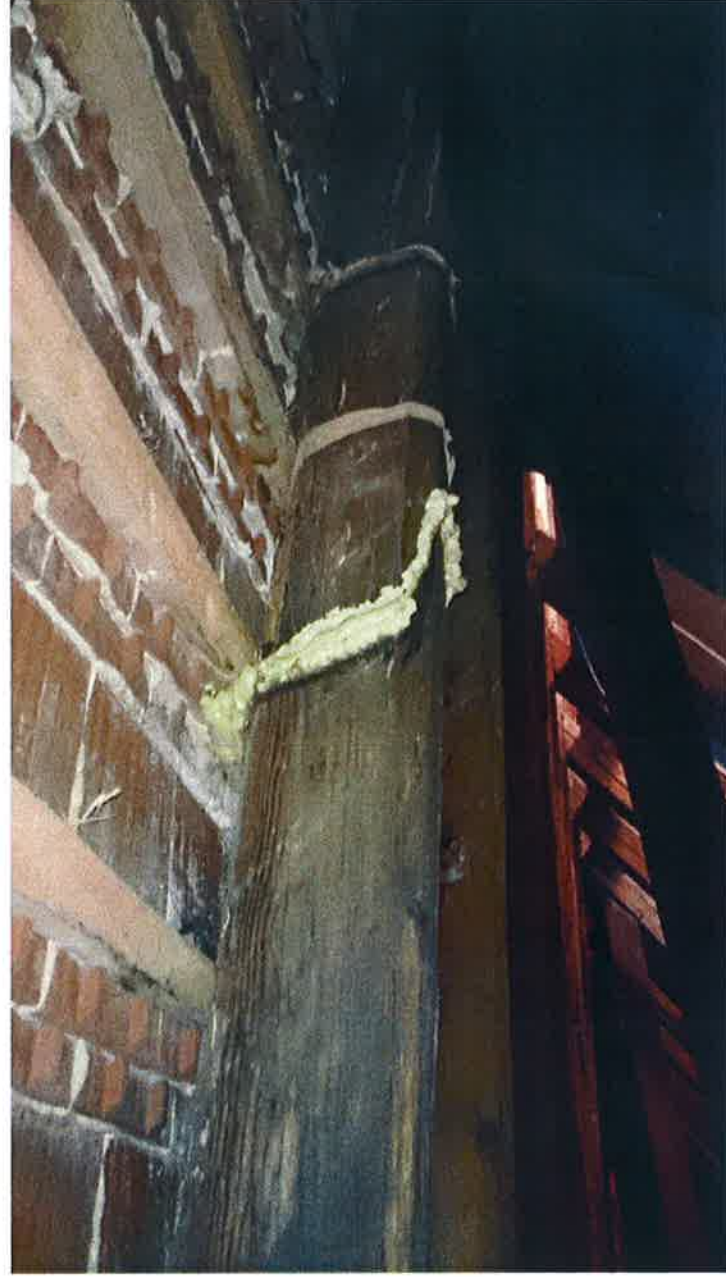
Fot. 5. Uszczelnienia krokwi dachu pianką poliuretanową – element do wymiany
