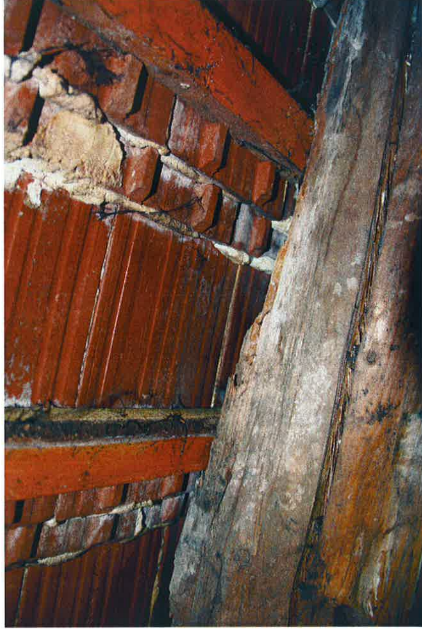
Fot. 7. Widok więźby dachowej – korozja krokwi od strony pokrycia dachu
