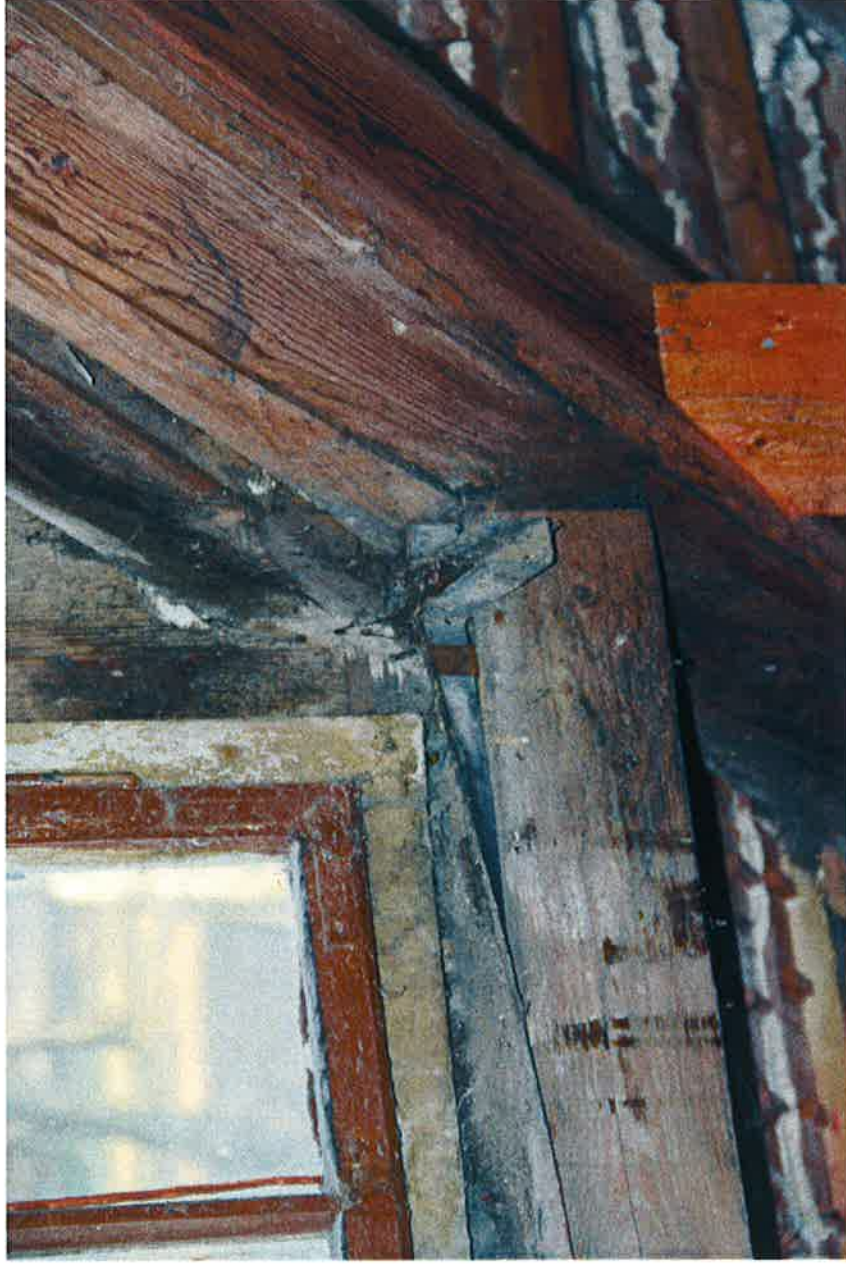
Fot. 16. Odwodnienie lukarny – do korekty i odtworzenia
