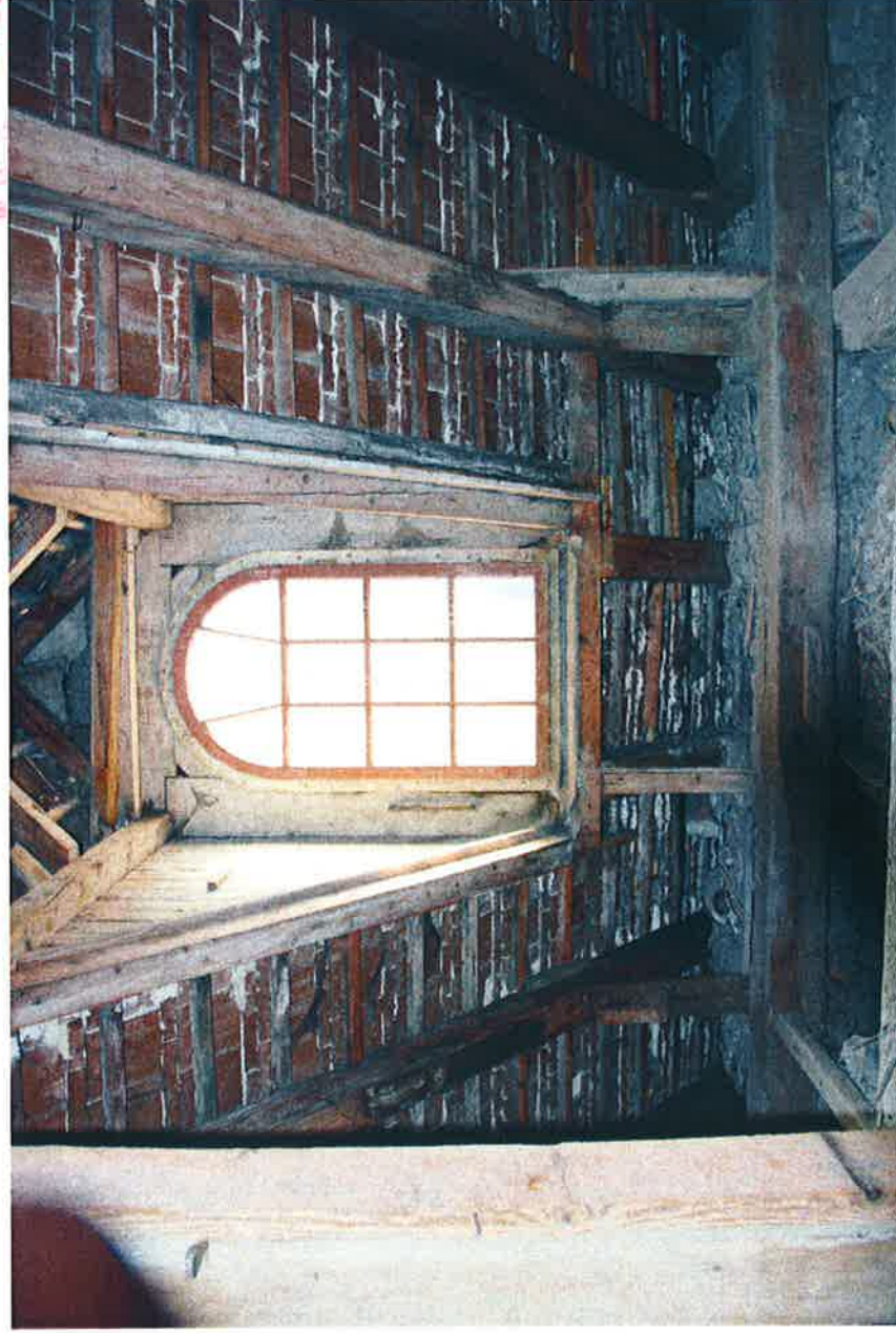
Fot. 21. Stolarka lukarn do wymiany z odtworzeniem podziałów szprosów
