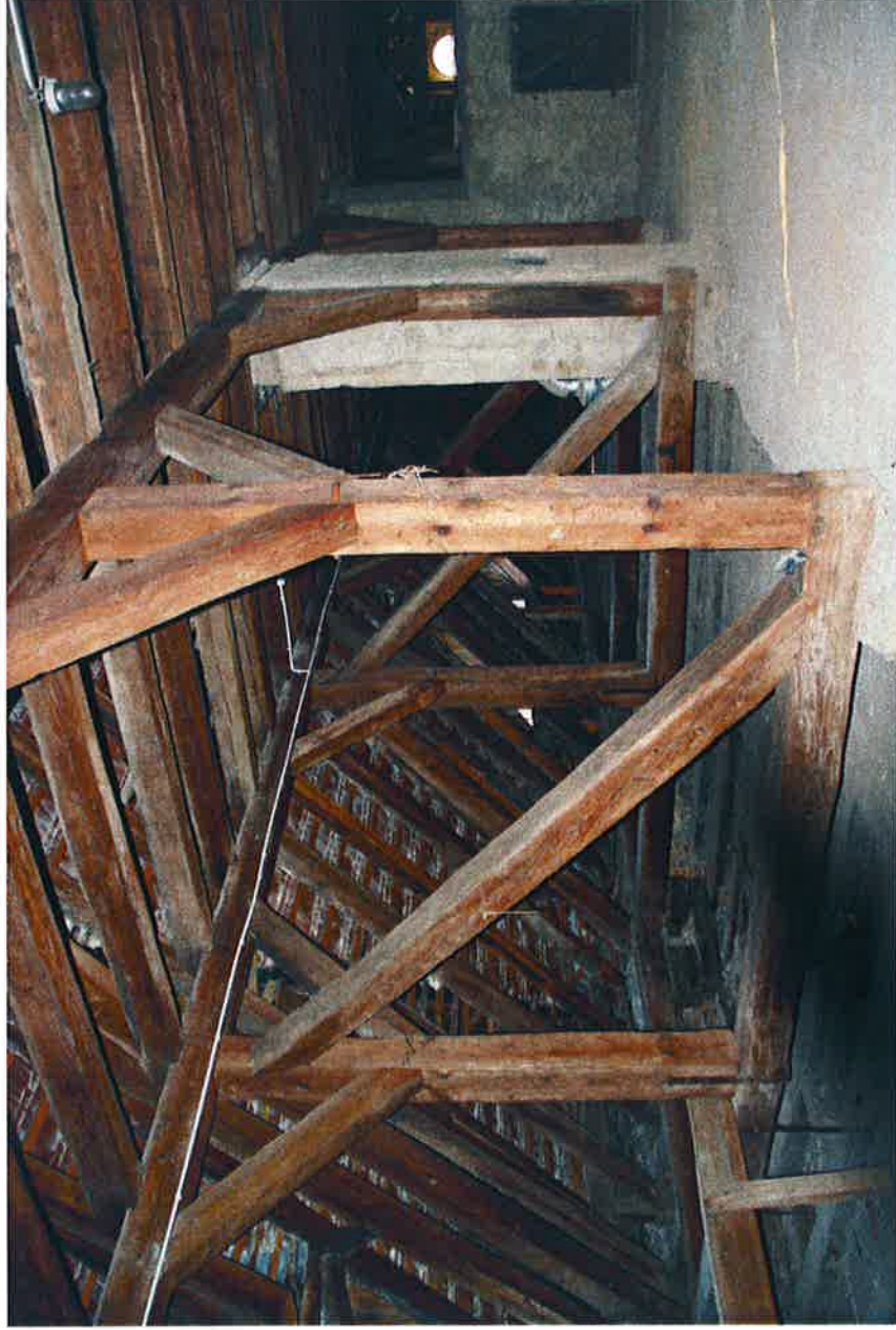
Fot. 23. Widok więźby dachowej – widok ścian stolcowych
