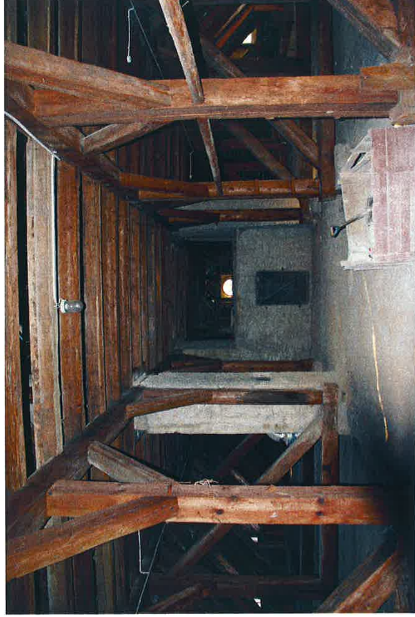
Fot. 22. Widok więźby dachowej – widok ścian stolcowych
