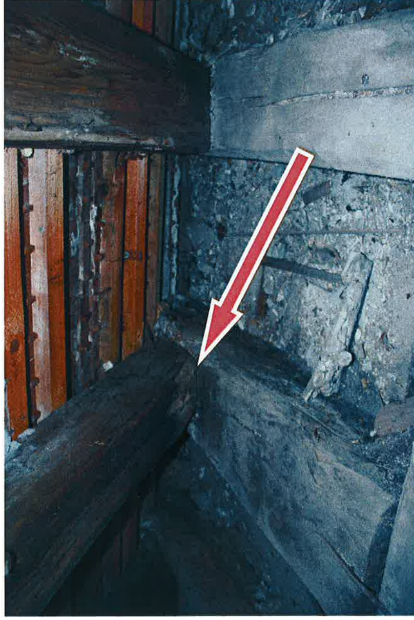
Fot. 13. Widok więźby dachowej – rozkład brunatny krokwi w wyniku zawilgocenia
