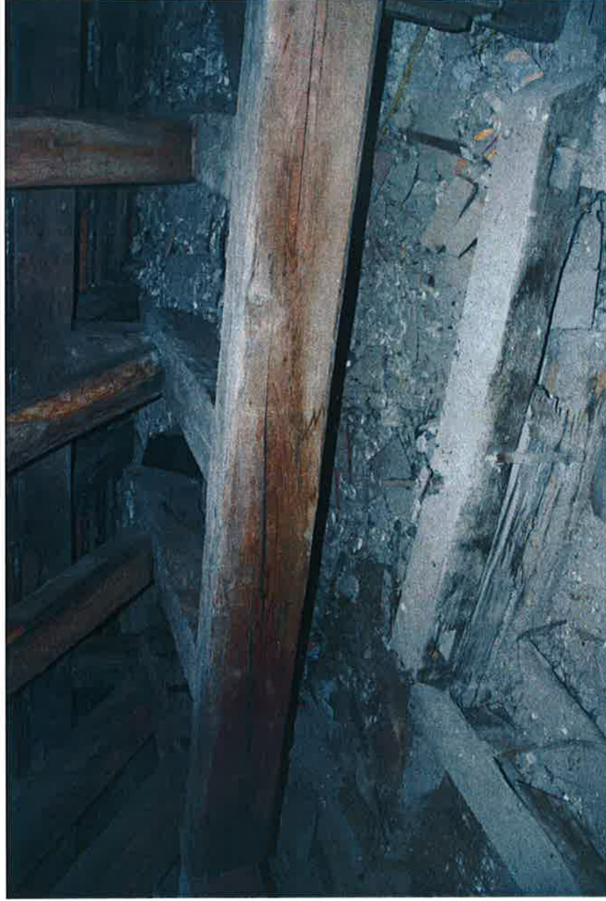
Fot. 10. Widok więźby dachowej – zagruzowaną część okapu – do oczyszczenia i poddaniu przeglądowi
