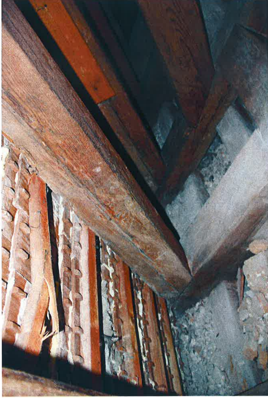
Fot. 19. Uszkodzenie łąty – łacenie dachu wykonać nowe o przekroju 4x6 mm.
