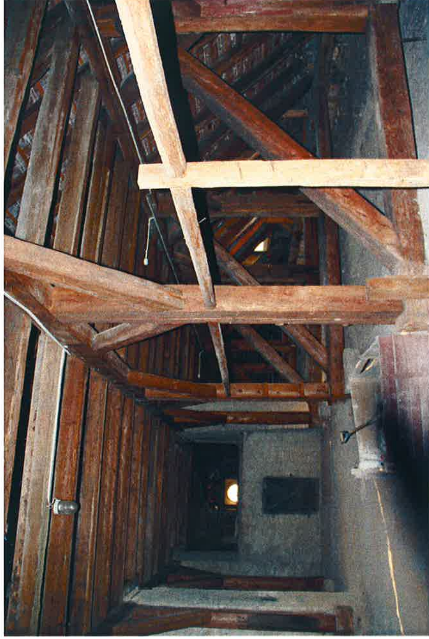
Fot. 24. Widok więźby dachowej – widok ścian stolcowych
